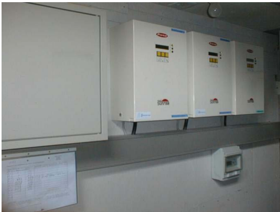
3 Wechselrichter, was man hört ist ein leises Summen
